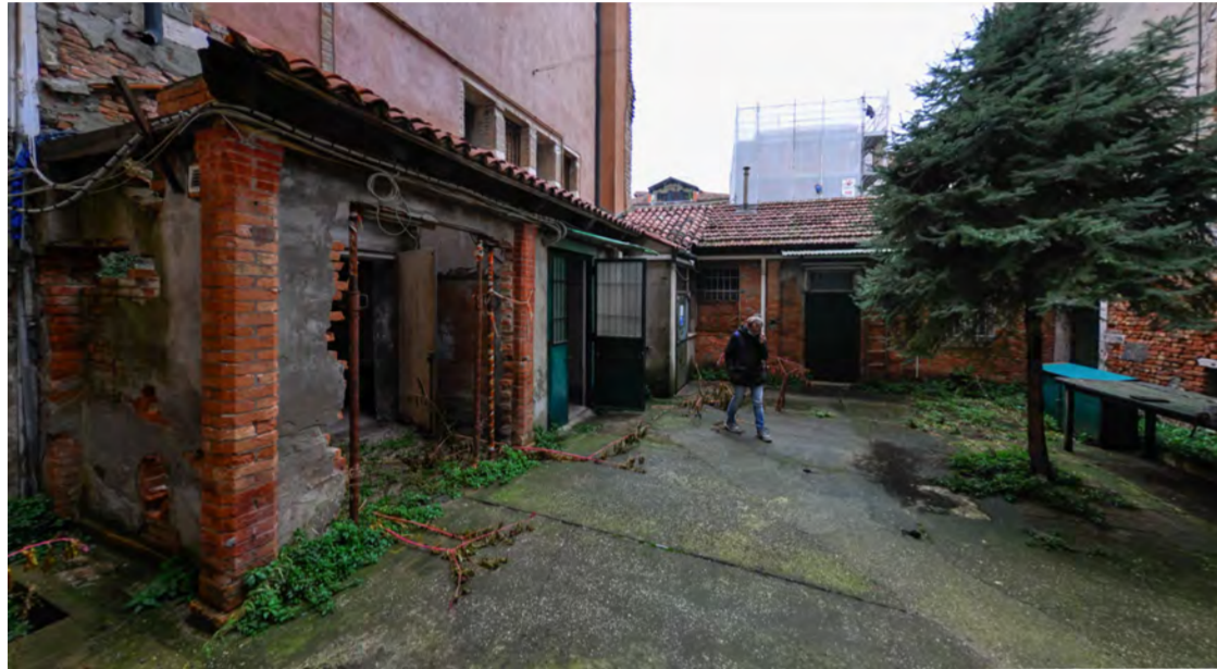
VISTA DELLE BARACCHE DA DEMOLIRE
