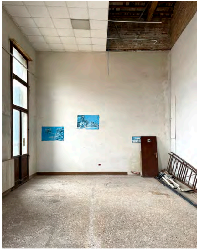
STATO ATTUALE DELLA STANZA IN CUI VERRÀ REALIZZATO IL SOPPALCO
