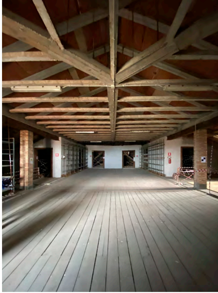
VISTA DEL SOTTOTETTO
