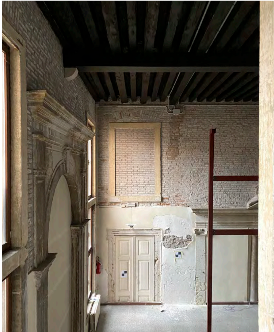
VISTA DALLA FINESTRA DELL'AMMEZZATO VERSO L'INTERNO DEL PORTEGGIO
