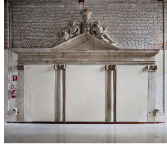
VISTA DEL PORTALE TAMPONATO
